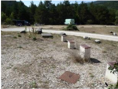
Station d'épuration du camping – dispositif d'infiltration
